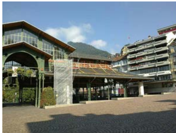
Marché couvert de Montreux Traitements et nourrissage des volets bois (parties extérieures) et exécution des nettoyages de vitrages et de la structure interne (lambrissage et acier)
