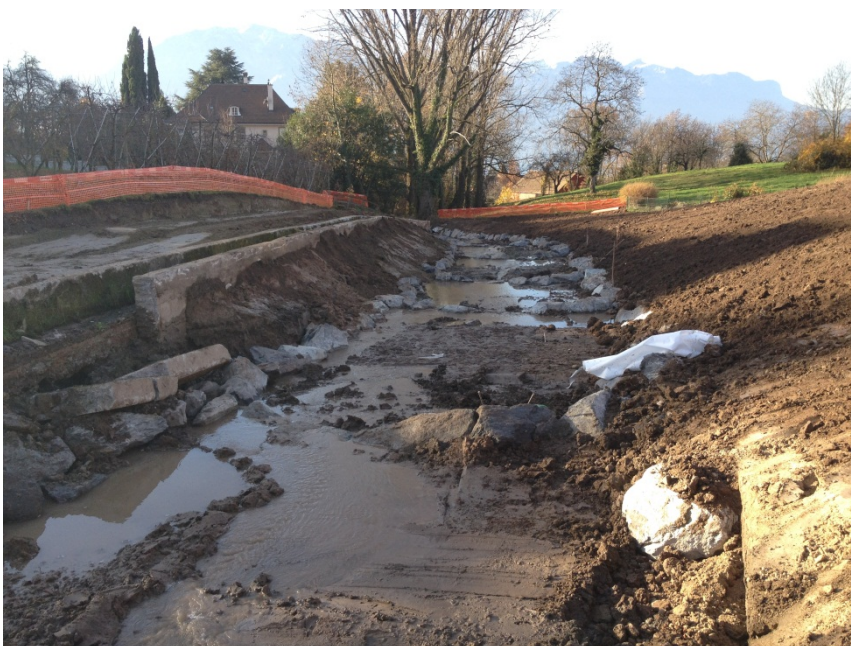
A gauche, on peut observer le canal bétonné et sur la droite, le nouveau tracé de la Maladaire.
