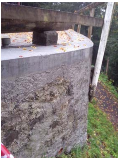
Stand de tir de Glion Consolidation du mur de soutènement de la terrasse avec une partie en béton armé
