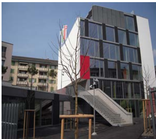
Maison de Quartier sur le site de Jaman 8, à Clarens
