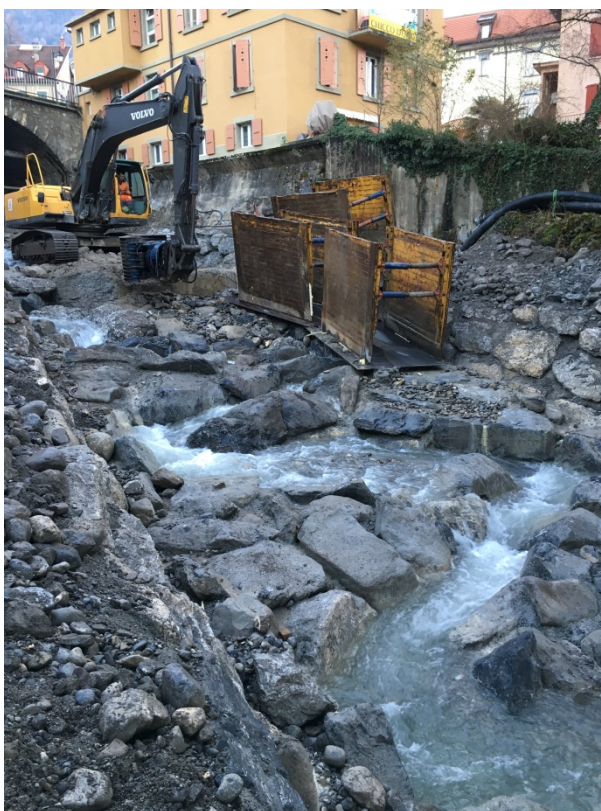
Création d'une rampe et d'un chenal pour les poissons
