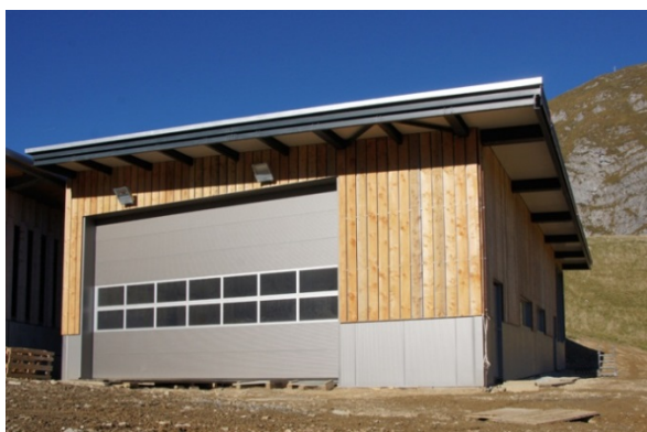
Abri à dameuse
