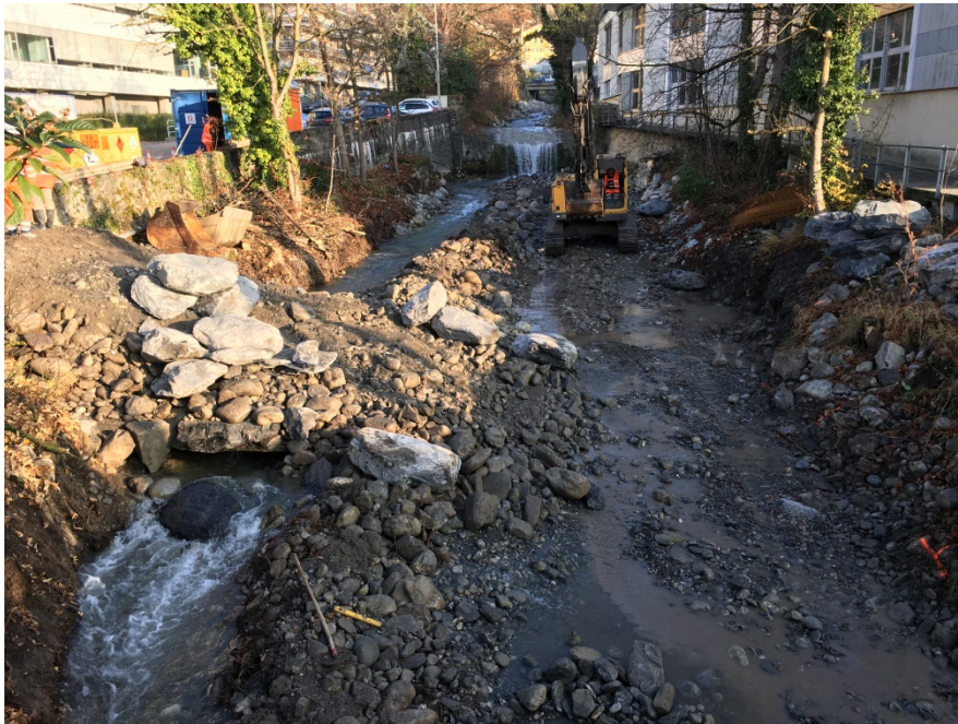
Déviation du ruisseau en rive droite. En arrière-plan, on distingue le seuil existant.
