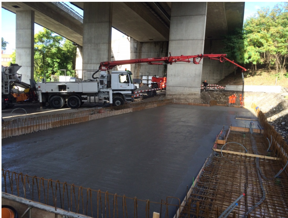
Déchèterie fixe en construction sous l'autoroute
