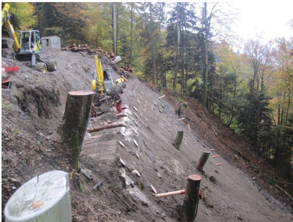
Réalisation d'un caisson en bois à la route des Avants
