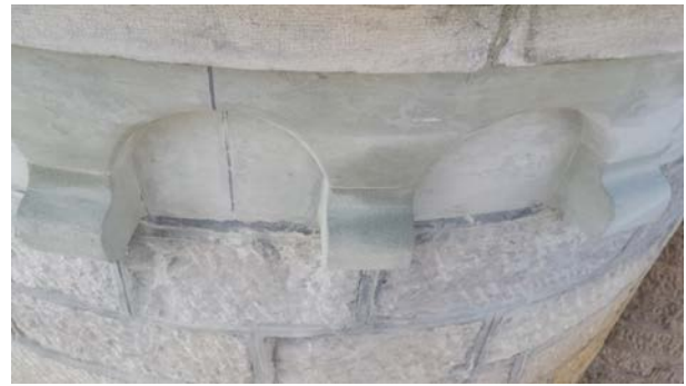
Eglise catholique de Montreux Restauration des joints des pierres de taille et hydrogommage des deux tourelles côté lac
