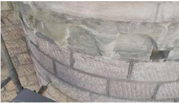
Eglise catholique de Montreux Restauration des joints des pierres de taille et hydrogommage des deux tourelles côté lac
