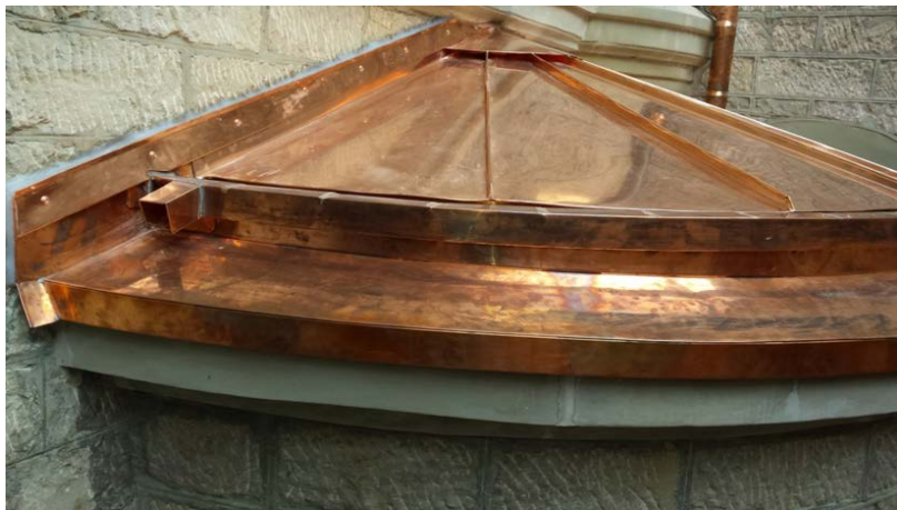
Eglise catholique de Montreux Réfection de la ferblanterie de la toiture du baptistère
