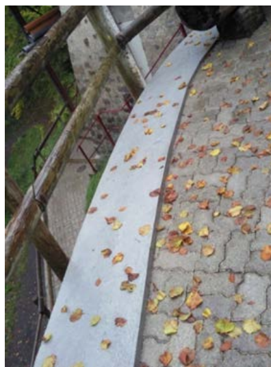
Stand de tir de Glion Consolidation du mur de soutènement de la terrasse avec une partie en béton armé
