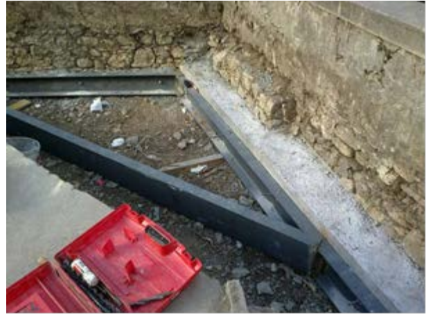
Rue du Marché 8, à Montreux Renforcement et sécurisation du mur de soutènement
