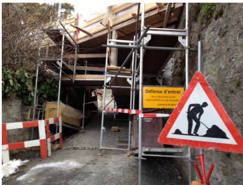
Passage inférieur du chemin des Vuarennas Sous Pertit
