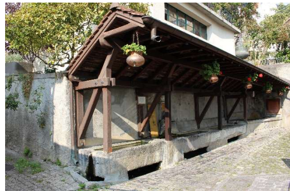
Fig. 10. Fontaine de Vernex, située à la rue du Centre alimentée par les eaux alcalines de Montreux, photographie Commune de Montreux, 2016
