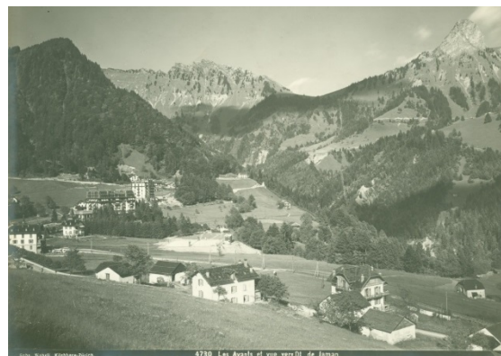
Fig. 9 : Les Avants, 1903-1905. Archives de Montreux, Fonds Wehrlé AG, PP247-18 27
